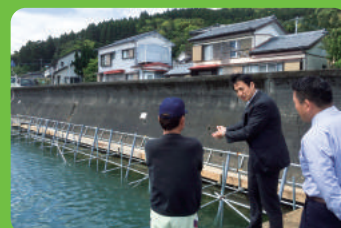
野島漁港等の津波対策について視察
