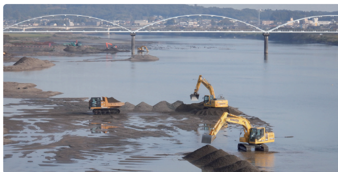
河道掘削が進む大淀川
