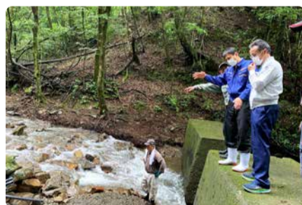
豪雨で被害を受けた現場視察 (国富町初木地区)
