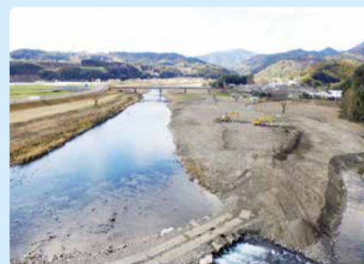
※2 綾北川の河道掘削 (国富町太田地区)
