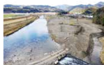
綾北川の河道掘削
