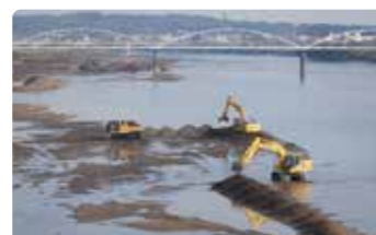
河道掘削が進む大淀川
