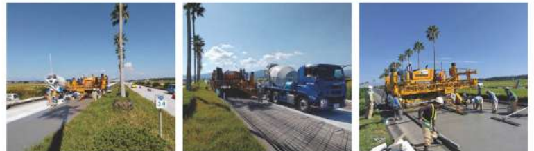
整備が進む宮崎南バイパス
